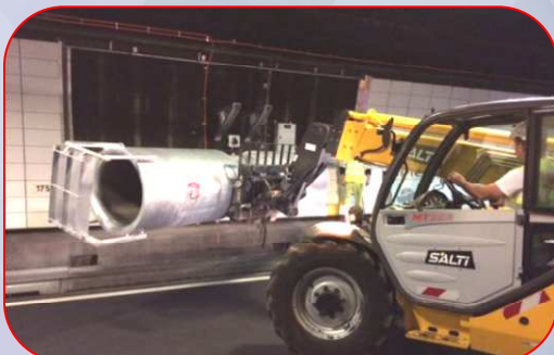
Pose d'accélérateur en pied droit Tunnel sous Fourvière
